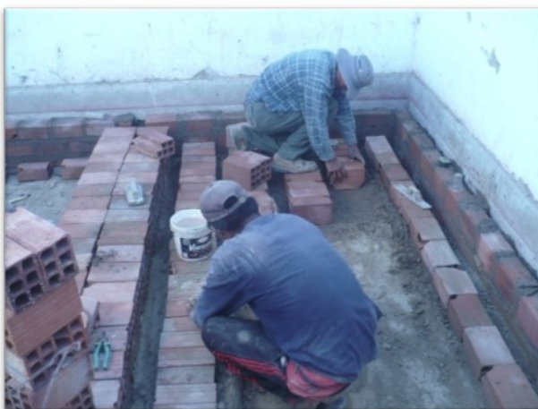
Figura N° 22: CONSTRUCCIÓN DE PISO RADIANTE
