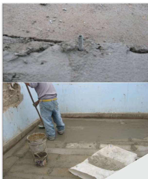
Figura N° 20: VACIADO DE PISO DE CONCRETO
