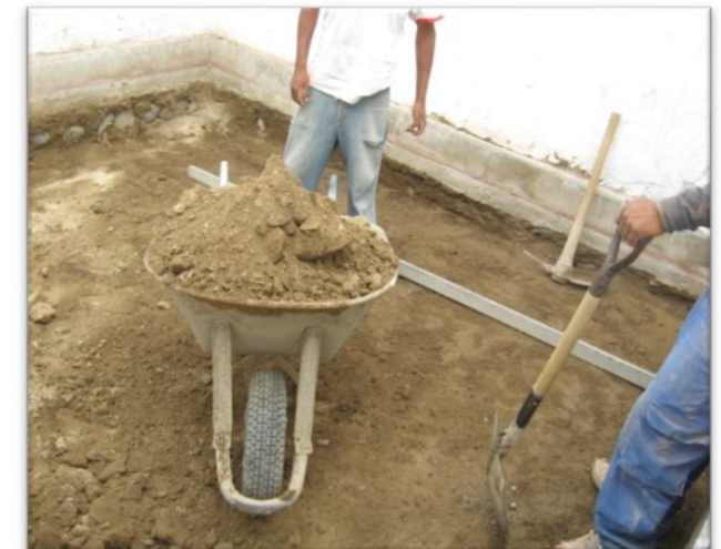
Figura N° 09: ELABORACIÓN DE ACUMULADOR DE CALOR
