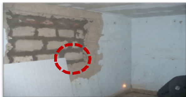
Figura N° 28: INSTALACIÓN DE SENSORES
