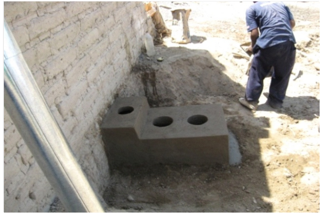
Figura N° 08: PROCESO DE ELABORACIÓN DE COCINA MEJORADA
