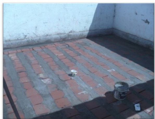
Figura N° 25: CONSTRUCCIÓN CON LADRILLO
