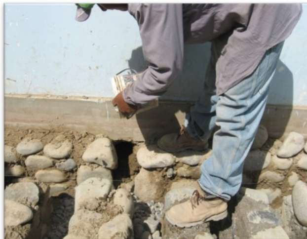
Figura N° 15: CONSTRUCCIÓN DE PISO RADIANTE
