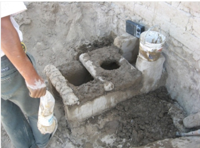
Figura N° 06: PROCESO DE ELABORACION DE COCINA MEJORADA
