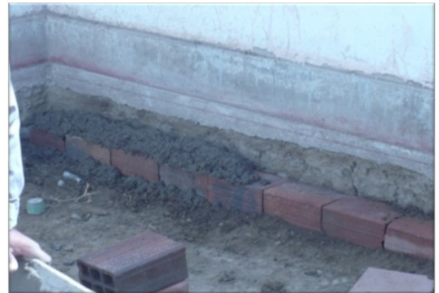
Figura N° 23: CONSTRUCCIÓN DE PISO RADIANTE
