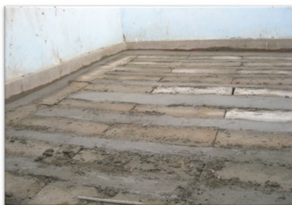
Figura N° 19: INSTALACIÓN DE BALDOSAS DE CONCRETO
