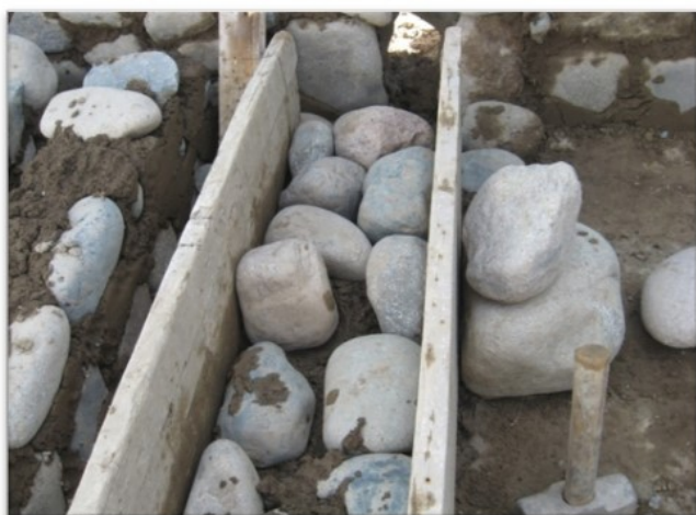
Figura N° 12: PROCESO DE ELABORACIÓN DE ACUMULADOR DE CALOR
