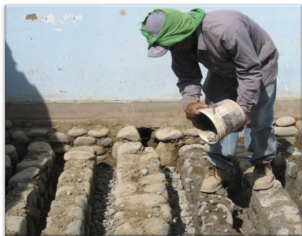
Figura N° 14: CONSTRUCCIÓN DE PISO RADIANTE
