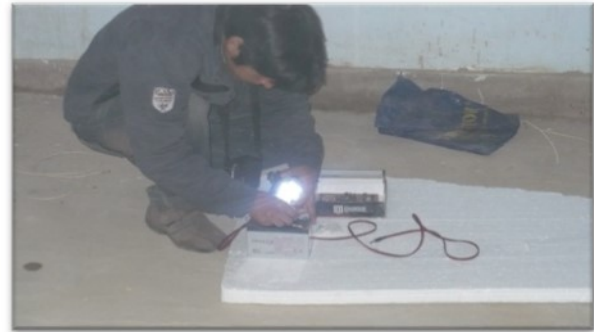
Figura N° 26: INSTALACIÓN DE SENSORES
