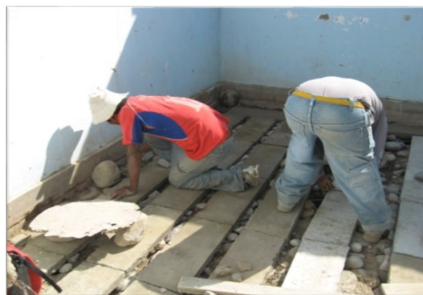
Figura N° 18: INSTALACIÓN DE BALDOSAS DE CONCRETO
