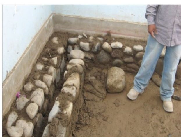
Figura N° 13: PROCESO DE ELABORACIÓN DE ACUMULADOR DE CALOR
