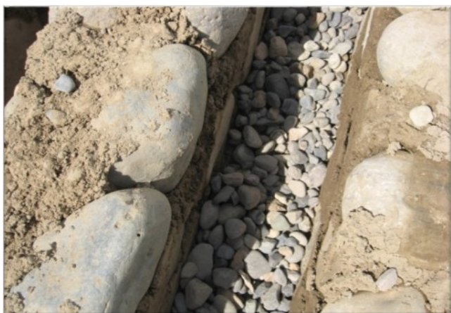
Figura N° 16: PROCESO DE ELABORACIÓN DE ACUMULADOR DE CALOR
