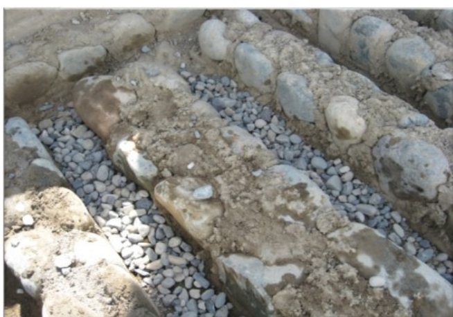
Figura N° 17: PROCESO DE ELABORACIÓN DE ACUMULADOR DE CALOR
