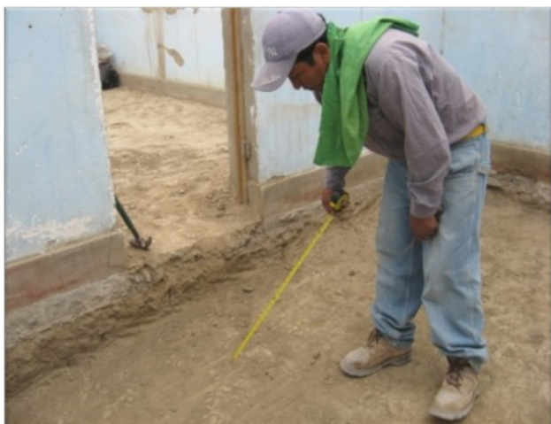
Figura N° 10: PROCESO DE ELABORACIÓN DE ACUMULADOR DE CALOR
