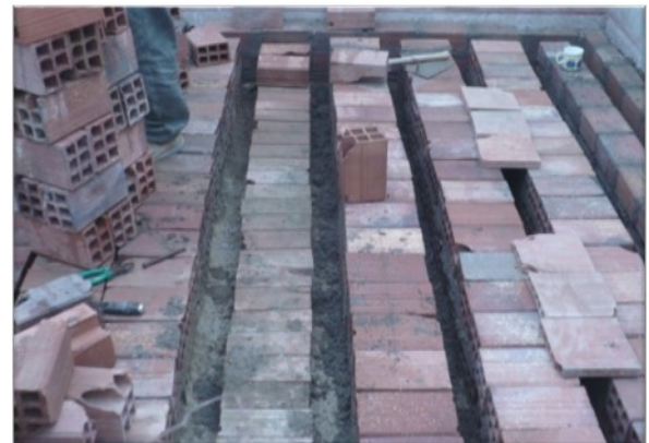
Figura N° 24: CONSTRUCCIÓN CON LADRILLO
