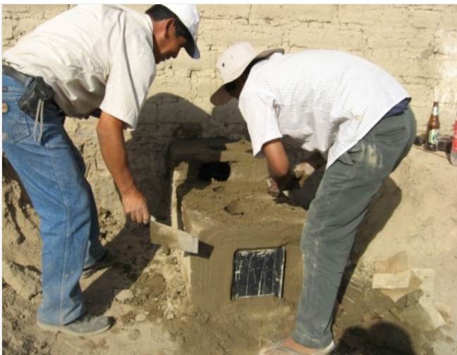
Figura N° 07: PROCESO DE ELABORACIÓN DE COCINA MEJORADA
