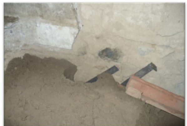
Figura N° 33: DUCTO DE SALIDA (CHIMENEA)
