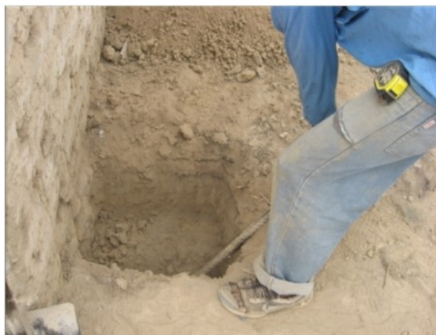
Figura N° 11: PROCESO DE ELABORACIÓN DE ACUMULADOR DE CALOR
